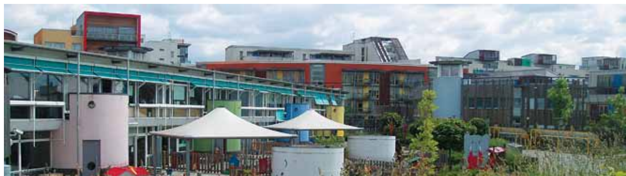
po lewej: Greenwich Millennium School w Londynie, proj.: Edward Cullinan Architects, 2000
